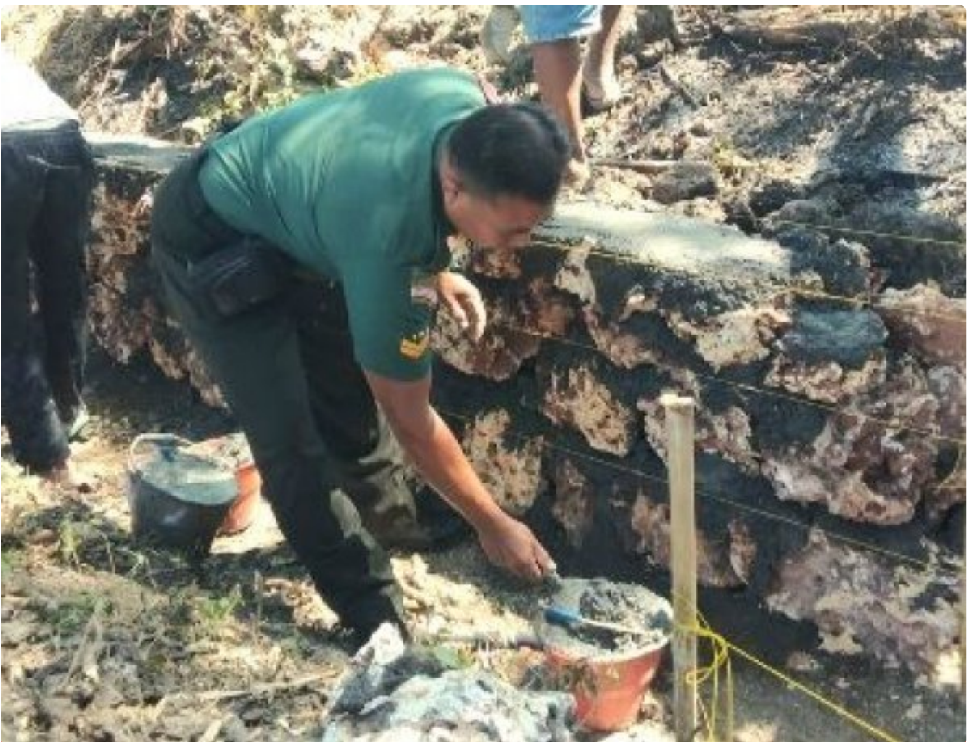
Babinsa Koramil 0829-12/Modung saat membantu pemasangan batu pembuatan irigasi
